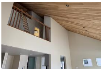
②羽目板の勾配天井 屋根断熱で2階も暑くない
